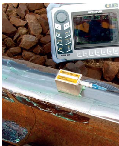
Rys. 9. Badanie złącza szynowego zgrzanego Fig. 9. Examination of the welded rail joint
