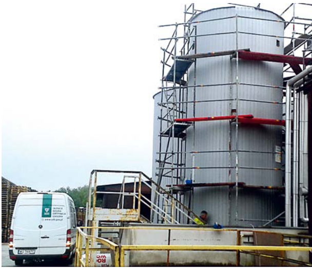
Rys. 6. Widok badanego metodą AE zbiornika magazynowego Fig. 6. The view of storage tank tested by AE method
