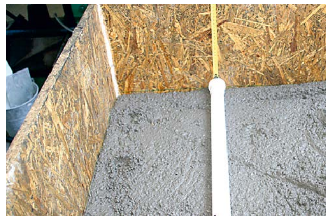
Rys. 7. Widok elementu podczas betonowania Fig. 7. View of the element during concreting
