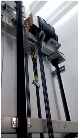
Rys. 2. Obiekt pomiarowy – liny nośne dźwigu osobowego. Fig. 2. Measuring object – traction ropes of passenger lift.
