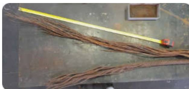
Rys. 4.3. Lina 40mm w miejscu przerwania.
