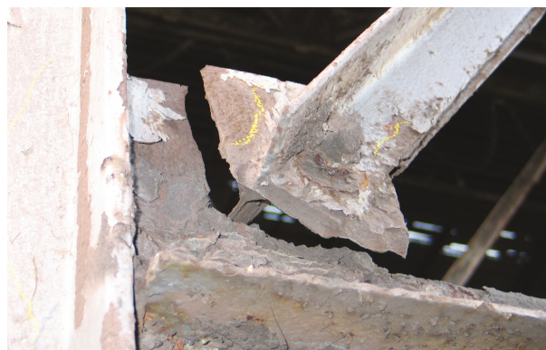
Rys. 12. Deformacje, perforacje i ubytki korozyjne dochodzące lokalnie do 90% stwierdzone dla wszystkich elementów stężających belki torowiska pomiędzy osiami 121-127,5 – obszar belki pomiędzy szynami zasypany skamieniałym pyłem [1].
