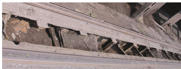
Rys. 10. Deformacje, perforacje i ubytki korozyjne dochodzące lokalnie do 90% stwierdzone dla wszystkich elementów stężających belki torowiska pomiędzy osiami 121-127,5 – obszar belki pomiędzy szynami zasypyany skamieniałym pyłem [1].
