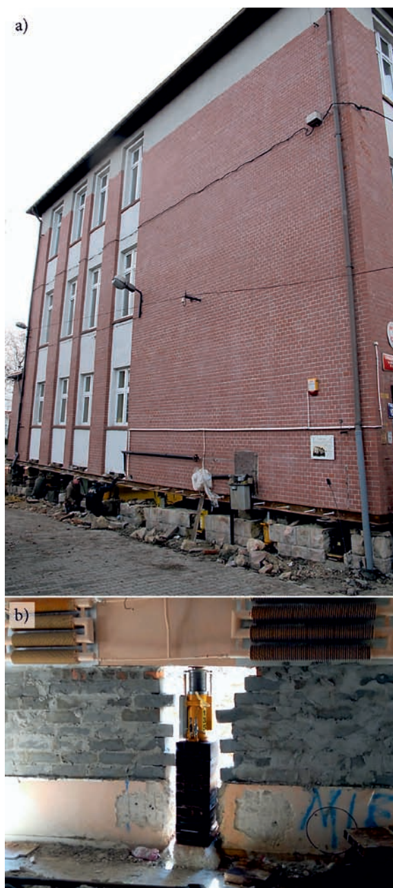
Rys. 2. Tymczasowe podpory budynku: a) układ podpór zabudowany w ścianie budynku, b) pojedyncza podpora złożona z siłownika i stosu stalowych elementów prostopadłościennych Fig. 2. Temporary supports of the building: a) system of the supports build in the wall of the building, b) single support consisting of jack and stack of cuboid steel elements
