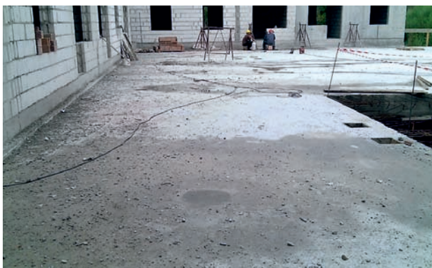
Rys. 2. Fragment płyty stropowej o niskiej wytrzymałości. Fig. 2. The fragment of the ceiling slab of a low strength.
