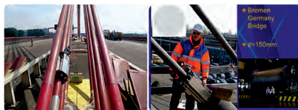
Rys. 11. Technologia LRM badania lin mostów podwieszanych w Niemczech
