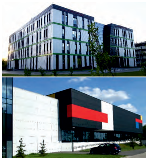
Rys. 1. Widok przykładowych elewacji wentylowanych z wykorzystaniem płyt włókniasto-cementowych na budynkach użyteczności publicznej
