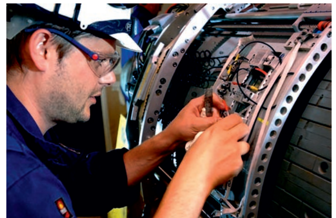
Fig. 3. End Ring Inspection Rys. 3. Badanie pierścienia końcowego
